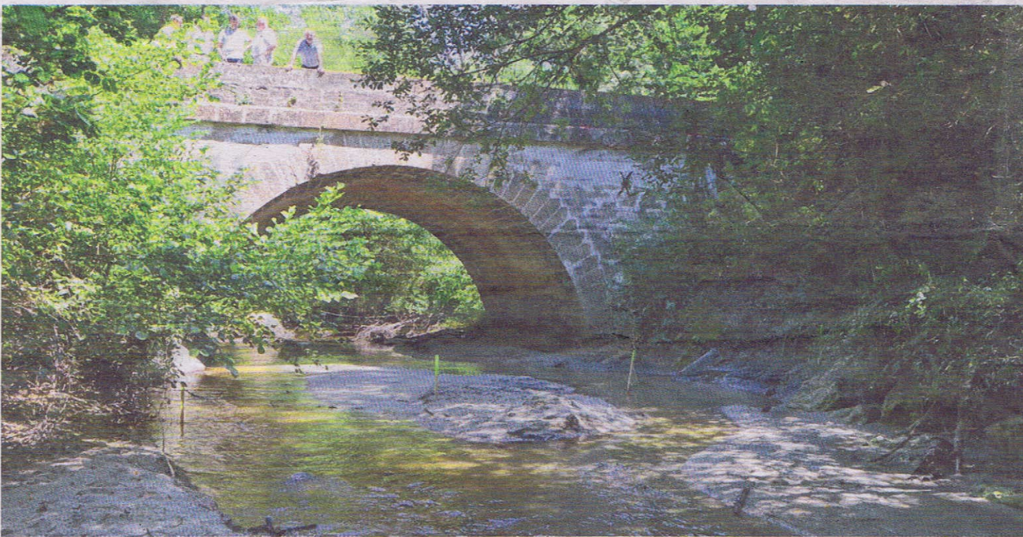
Le pont de la Baraque va être démolé puis reconstruit de sorte à favoriser l'écoulement de la Saye. PHOTO J.P.
