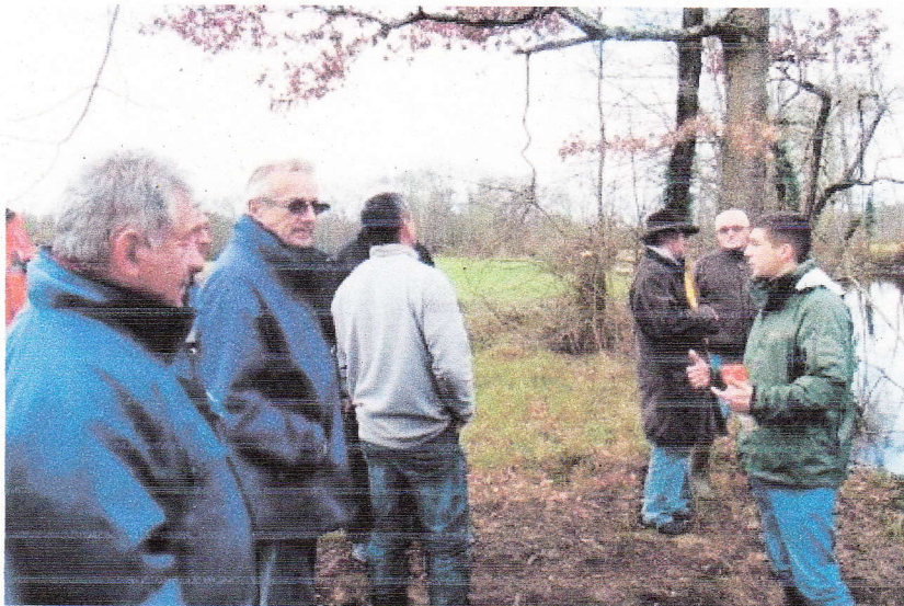
Délégués du syndicat des Trois Rivières et l'entreprise Isle et Drone de Porchère en réunion de chantier. (Photo J. G.)
